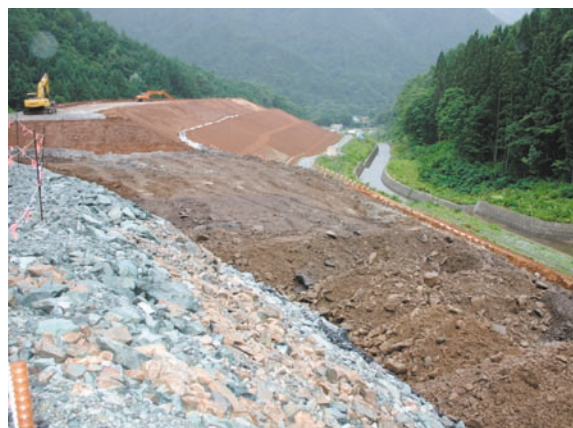
図3 造成中のズリ処分場（手前：一般型、後方：管理型）
