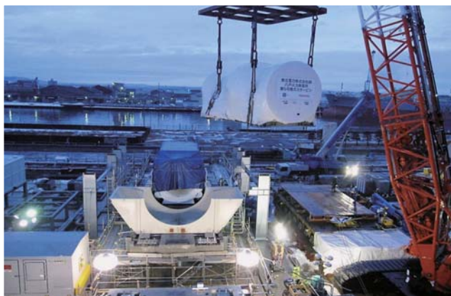
5号機ガスタービンの据付 (平成24年3月)
