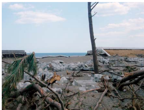
写真1 崩壊した津波防潮堤（岩手県野田村）
