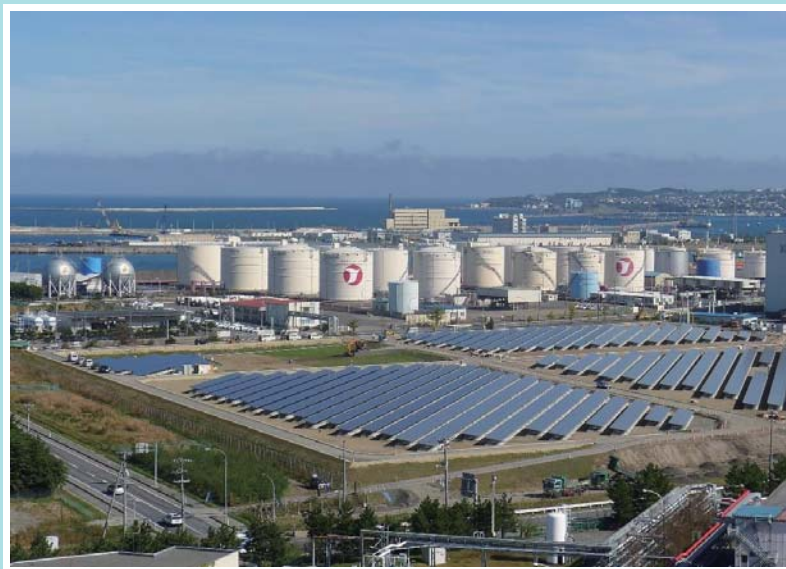
八戸太陽光発電所
