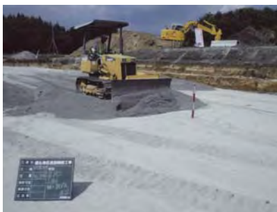
道路舗装工事
