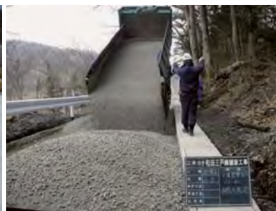
路盤材施工
