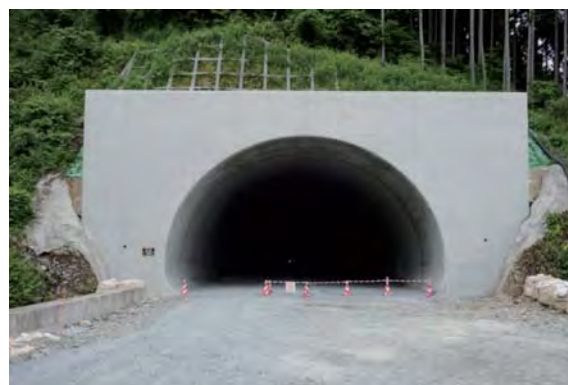
写真2 復興支援道路におけるコンクリート構造物の品質確保の取組み
