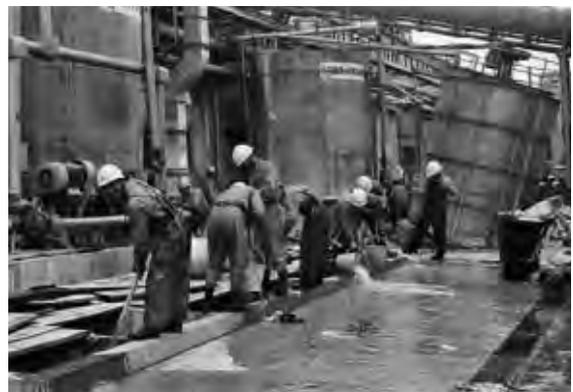
傾いたタンクと送水管復旧作業
