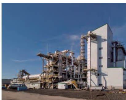
廃プラ炭化炉施設
