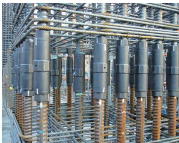
ネジテツコン施工
