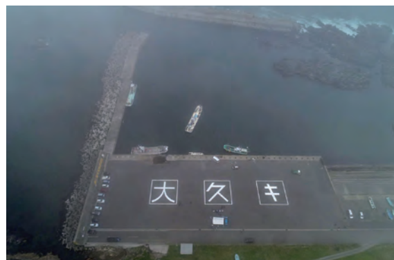
上空150mからの空撮画像
