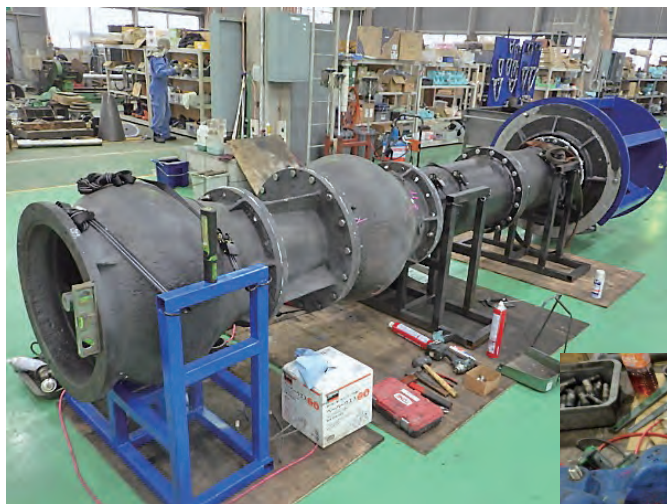
全長10mを超えるポンプの整備
