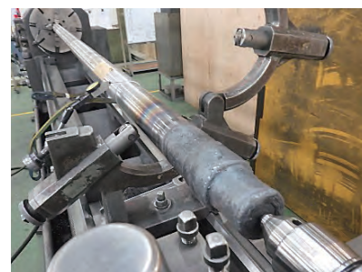
シャフト補修
